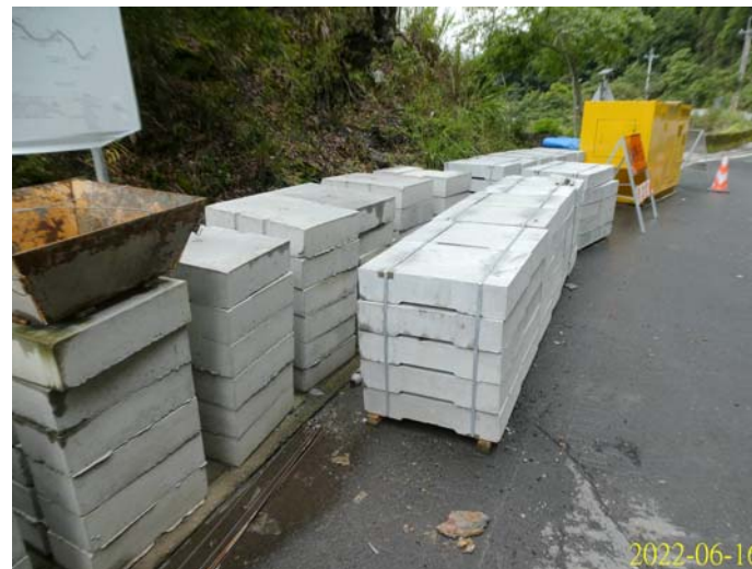
預鑄混凝土溝蓋板示意圖
