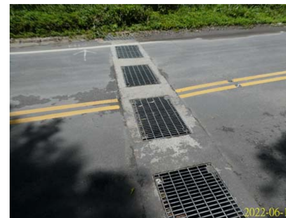
混凝土橫截溝(B型)示意圖
