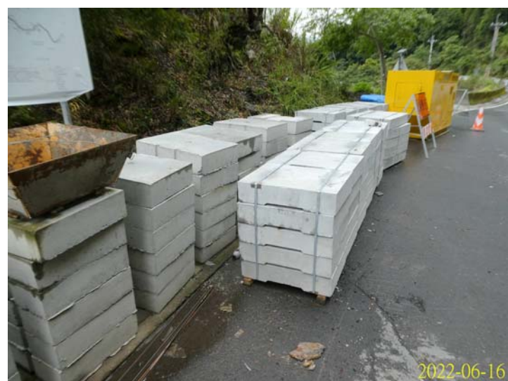
預鑄混凝土溝蓋板示意圖
